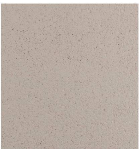
ESA01 - UHPC SOFFIT
