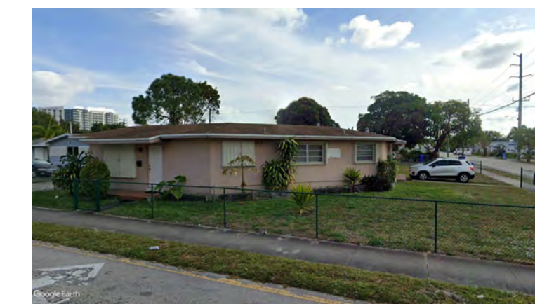
F STREET VIEW PHOTO 133 N 24 AV HOLLYWOOD N.T.S.
